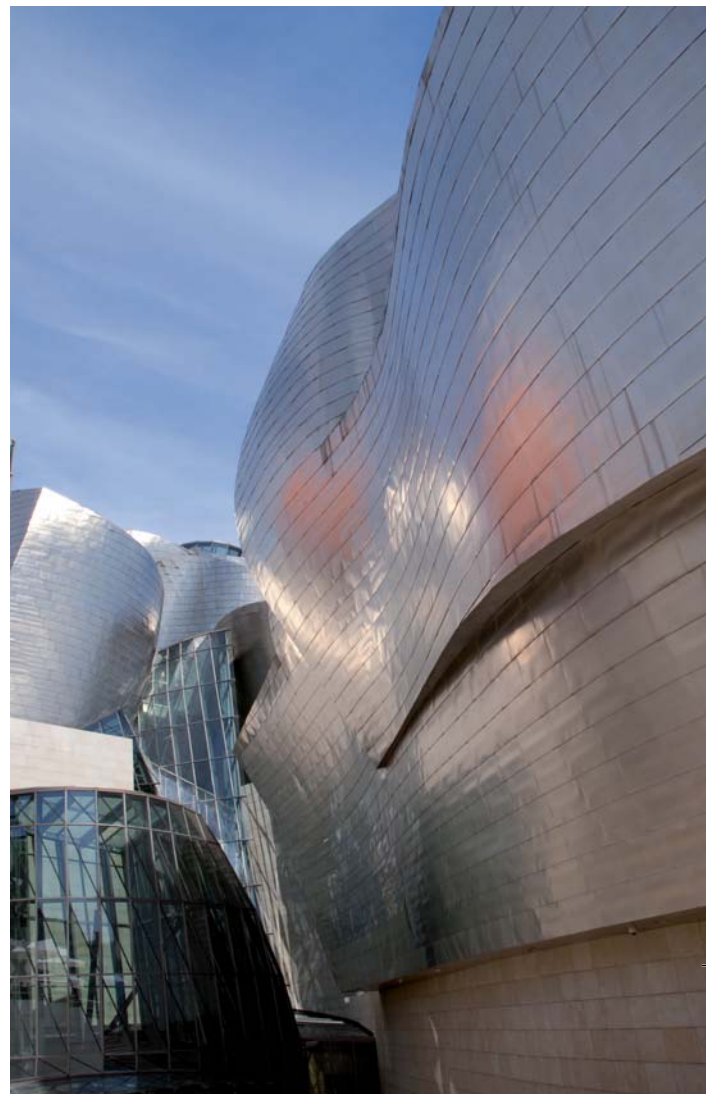
Het Guggenheim-museum in Bilbao is een mooi voorbeeld van de toepassing van titaan als gevelbekleding (foto: Ahisgett/Flickr)
